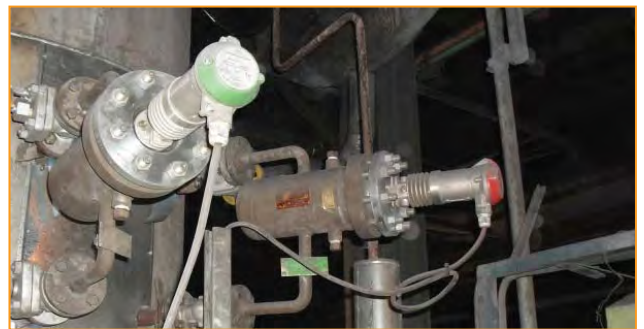
Trimod Besta Interruptor de nível tipo: HAA 22C01 041
