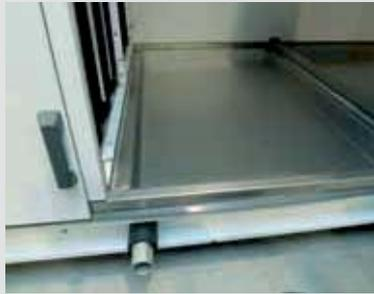
Tabuleiro de recolha de condensado em aço inoxidável, inclinado em todas as direções, em conformidade com as normas relevantes
