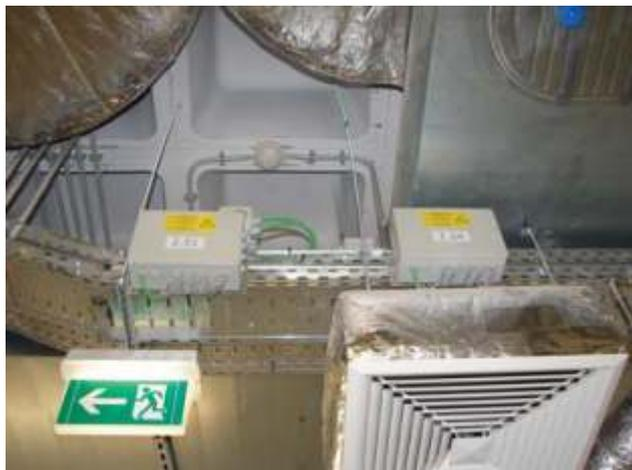
Desta forma em caso de deteção de incêndios pela SADI, todos os registos corta-fogo e desenfumagem colocam-se em posição de emergência em menos de 10 segundos. Compartimentação e desenfumagem de forma rápida e simples. Uma vez reposta a situação pela SADI, o sistema TroxNetCom LON é informado e reposiciona todos os registos para assegurar o normal funcionamento da instalação.
