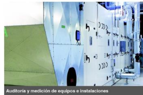
Auditoría y medición de equipos e instalaciones
