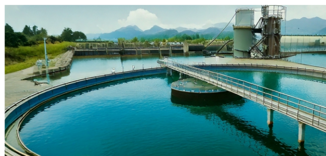
Tratamento de água – tanque biológico
