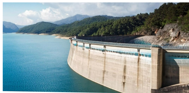
Barragem – Furo piezométrico
