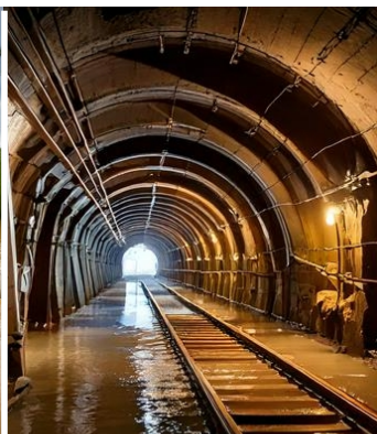
Minas Desaguamento água subterrânea
