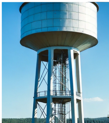
Água Potável Reservatório vertical
