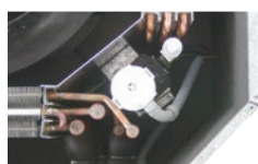
Bomba de condensados integrada em todos os tamanhos
