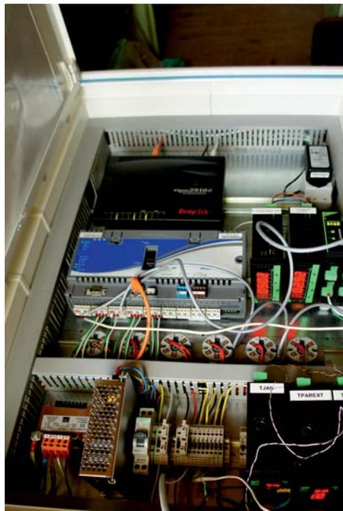
QUADRO ELÉCTRICO COM O AUTOMÓTATO E ROUTER 3G
