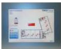
O sistema comunica com os módulos de registos corta-fogo, registos de desenfumagem e detectores de fumo permitindo assim controlo flexível e fiável de todos os elementos da rede.
